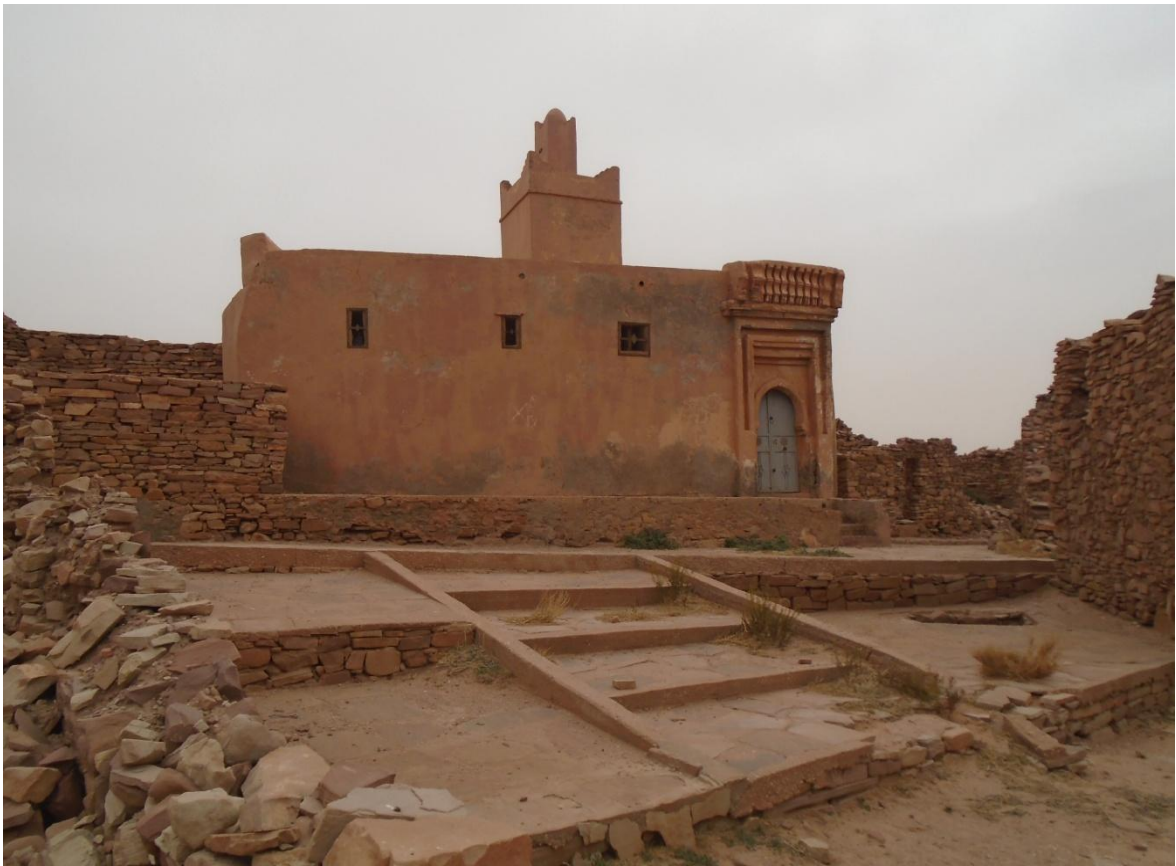
الصورة رقم 40: استعمال الحجارة المصفحة في البناء وتبليط الأرضيات والساحات من عمل الطالب
