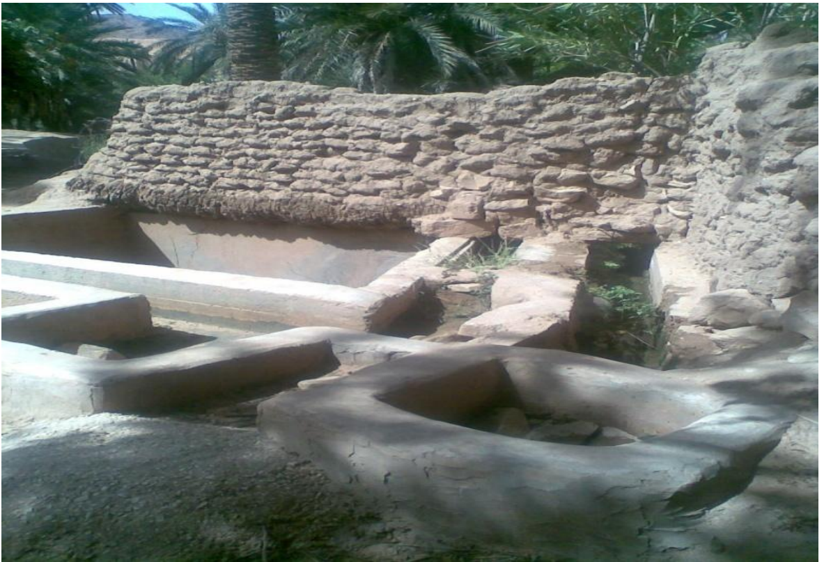
الصورة 08: طريقة السقي وتوزيع المياه عن طريق الخزان (الماجن) والساقية من عمل الطالب
